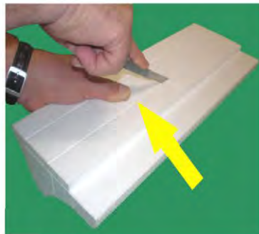
Untere Dämmung an Markierung zuschneiden
