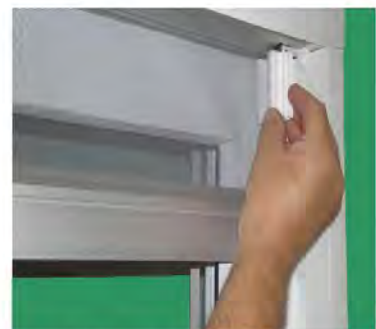
Reststück in vorhandener Lücke am Adapterprofil einsetzen
