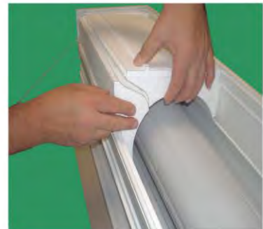
Dämmung in RK einsetzen
