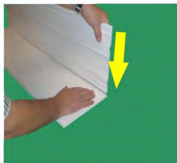
Außenblende und Deckelblende zusammenfügen
