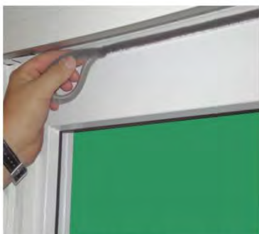
Bürste 6,7 x 9 ins Basisbrett einschieben
