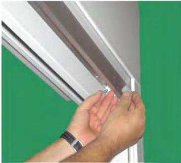
Stopper an Rollladenendschiene entfernen
