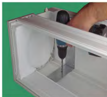
Loch für Raffstorehalterung bohren
