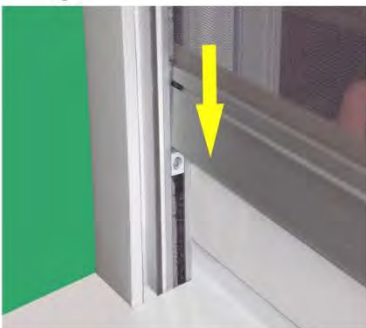
Gegenüberliegenden IS-Riegel mit Zugschiene runterschieben
