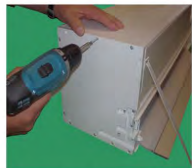
Entsprechend der Öffnungsart eine Blende verschrauben
