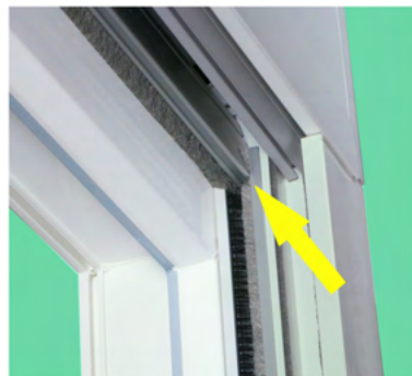
Gleichzeitig außen die Zugschiene in die IS Laufnut einführen Achtung: Zugschiene befindet sich hinter dem Rollladenpanzer
