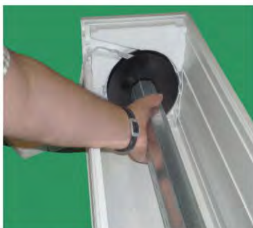
Welle mit Gurtscheibe in RK einsetzen
