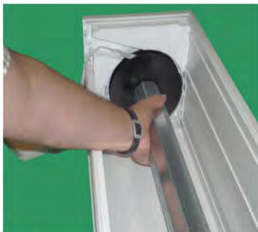
Welle mit Gurtscheibe in Rollladenkasten einsetzen
