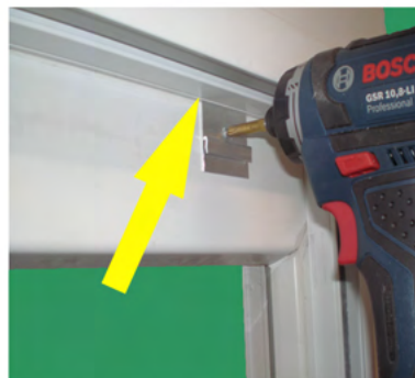
Klemmstücke für Adapter und U-Profile an Blendrahmenaußenkante anschrauben (ca. 30 cm Abstand)
