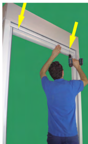
U-Schiene oben beidseitig vorbohren und an Schallschutzprofil anschrauben
