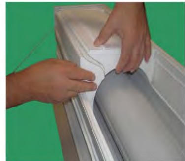
Dämmung in RK einsetzen
