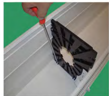
Doppelkopfstück beidseitig im RK verschrauben (3,9 X 9,5)
