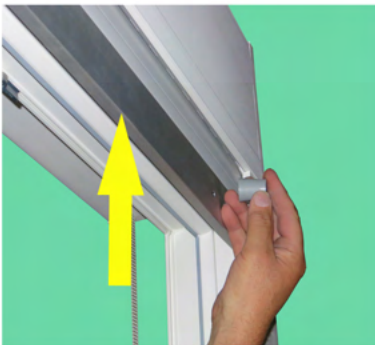
Stopper entfernen, Endleiste in den Rollladenkasten schieben
