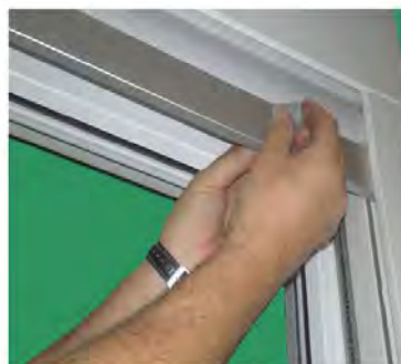
Rollladenendschiene positionieren (z.B. Stopper anbringen)
