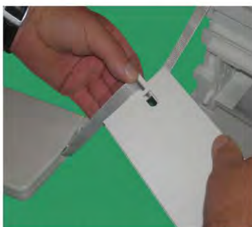
Gurtdurchführung in Ausfräsung der Reviblende einsetzen
