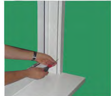
Sicherungsschraube unten in Rolladenführung eindrehen
