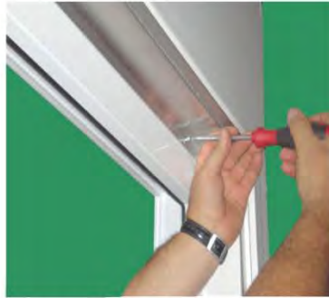
Schrauben an Abdeckung Revi außen lösen
