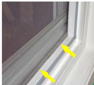
Bürstendichtung muß dicht anliegen und IS-Gaze muß gleichmäßig gespannt sein
