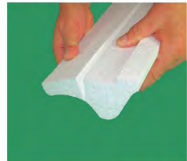
Dämmung an vorhandener Markierung abschneiden und durchbrechen
