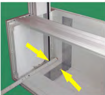
Abstand Mitte Raffstoreführung zur Außenblende auf Winkel übertragen ( 45 mm )
