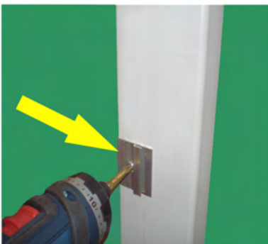
Klemmstücke für Adapter und U-Profile an Blendrahmenaußenkante anschrauben (ca. 30 cm Abstand)
