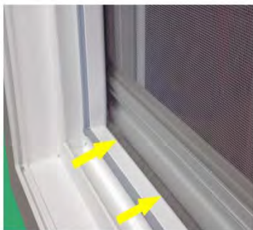
Bürstendichtung der Zugschiene muß innen dicht am Blendrahmen anliegen
