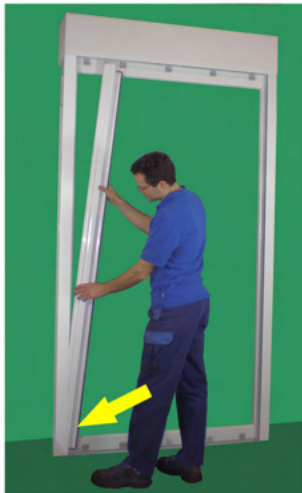
Fertige IS-Türkassette unten in Adapter einstellen
