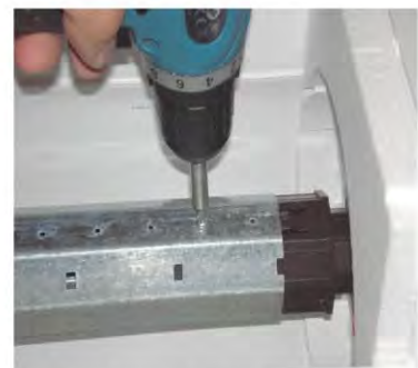
Walzenkapsel mit Welle verschrauben
