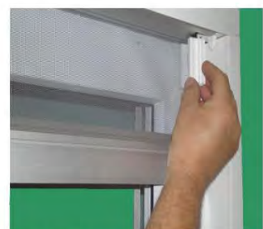
Reststück in vorhandener Lücke am Adapterprofil einsetzen
