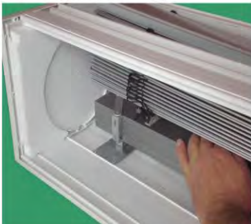
Raffstorepaket einhängen und seitlich vermitteln
