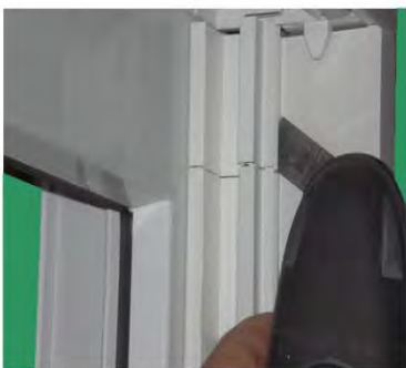
Adapterprofil an vorhandener Markierung ausschneiden Achtung: Reststück wird noch benötigt!
