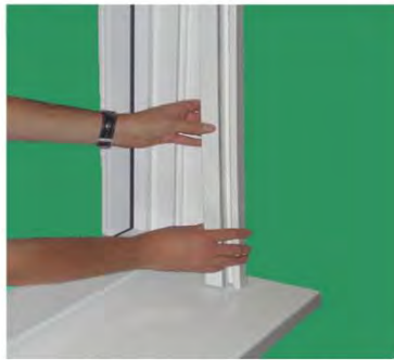
Rollladenführung ausbauen
