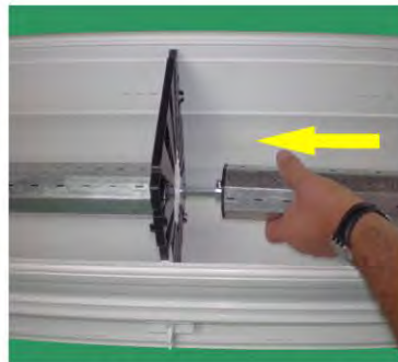
2te Welle auf Vierkant des Doppelwellenbolzens schieben
