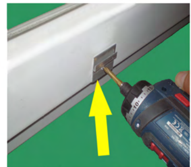
Klemmstücke für Adapter und U-Profile an Blendrahmenaußenkante anschrauben (ca. 30 cm Abstand)
