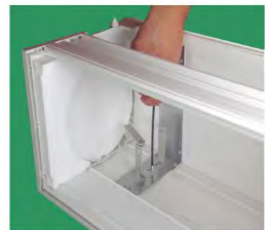
Raffstorehalterung auf Winkel mit Durchgangsschraube, großer U-Scheine und Mutter befestigen
