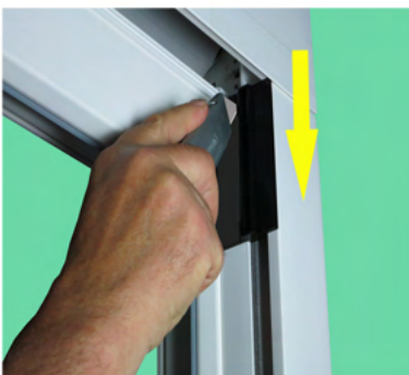
RLS außen mit Cutermesser aufschneiden
