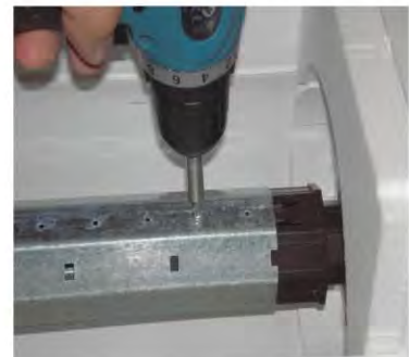
Walzenkapsel mit Welle verschrauben
