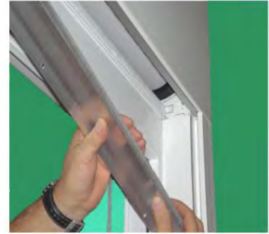
Abdeckung Revi außen entfernen
