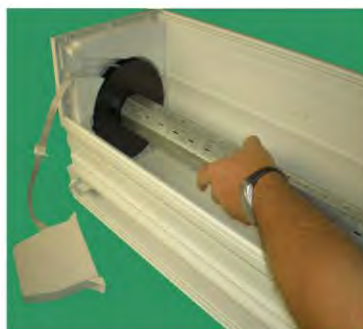
Gegenseite mit Gurtscheibe in Lagerscheibe einsetzen
