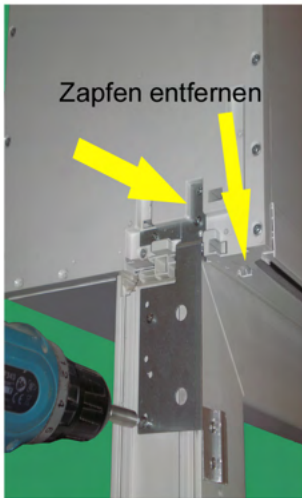
Befestigungsstiel auf Adapterseite in Aussparung RA einsetzen und befestigen
