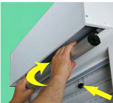
Zugschnur nach außen durchführen und Kassette über Basisbrett in Rollladenkasten einsetzen
