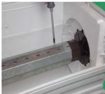
Walzenkapsel in Lagerscheibe teleskopieren
