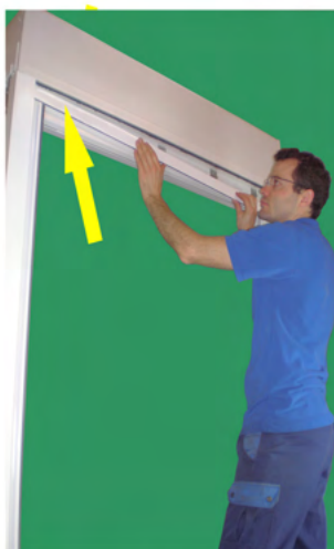
U-Schiene oben in Klemmstücke einsetzen
