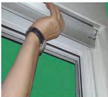
gegenüberliegende Seite durch Ausklinkung im Adapter in RK einführen
