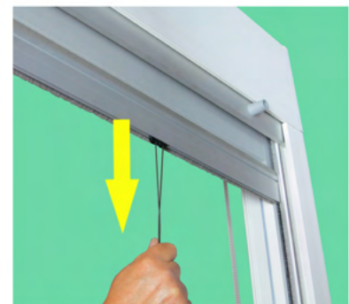
Zugschiene nach unten ziehen und Funktion überprüfen
