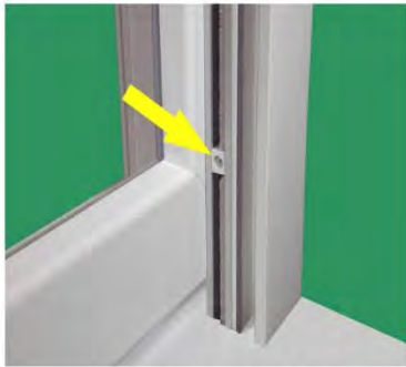
IS-Riegel beidseitig etwa auf Blendrahmenhöhe schieben
