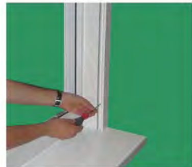
Sicherungsschraube unten in Rollladenführung eindrehen
