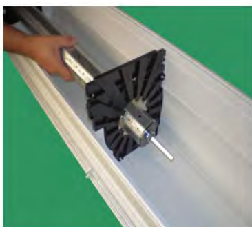
Welle mit Doppelwellenbolzen durch Mittellager schieben
