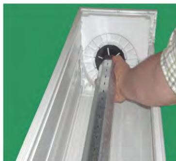
Gegenüberliegende Walzenkapsel teleskopieren
