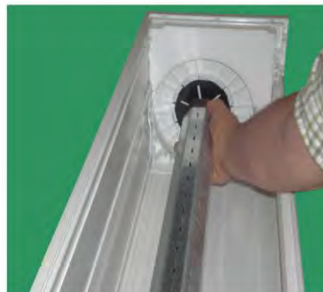
Gegenüberliegende Walzenkapsel teleskopieren
