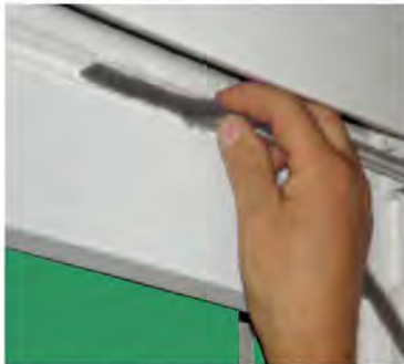
Bürstendichtung 6,7 x 9 mm in Basisbrett einschieben
