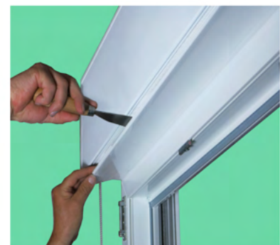
Revideckel öffnen, unteren Dämmkeil entnehmen
