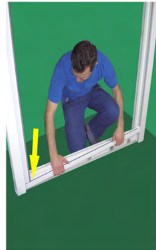
U-Schiene unten in Klemmstücke einsetzen
