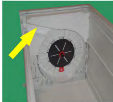
Kopfstückdämmung in Kopfstücke einsetzen
