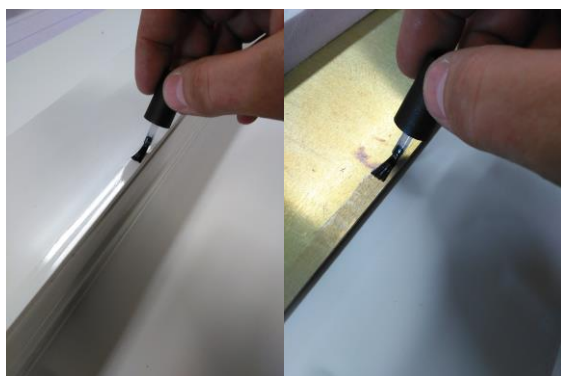
5. Aplikacja aktywatora (zalecana) - naniesienie aktywatora na miejsca połączenia klejonych powierzchni i taśmy klejącej. Aplikację należy przeprowadzać tylko w niezbędnej szerokości i w jednym kierunku.
