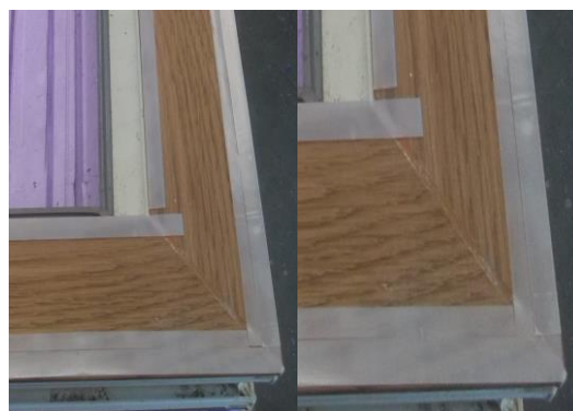
6. Przyklejenie dwustronnych taśm samoprzylepnych do ramy skrzydła. Z zewnętrznej strony obwodu klejonej powierzchni skrzydła drzwi należy przykleić taśmę o szerokości min. 15 mm, przy czym spójnie, bez żadnych szczelin. Z wewnętrznej strony zakłada się taśmę o szerokości min. 10 mm, połączenia między pojedynczymi stronami są luźne, tzn. z przerwami.
